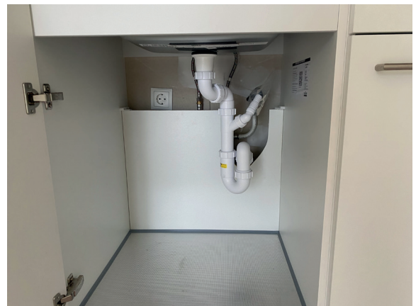
Gootsteenkastje met aansluitingen vaatwasser
